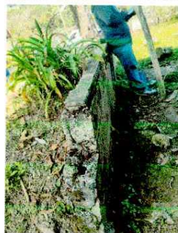
Foto 4: REPARACION DE MUROS DE CONTENCIÓN
