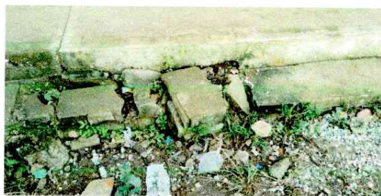
Foto 5: LOSA DE PATIO
