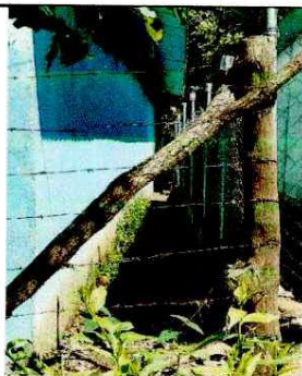
Foto 3: CERCO O MURO PERIMETRAL DE MALLA
