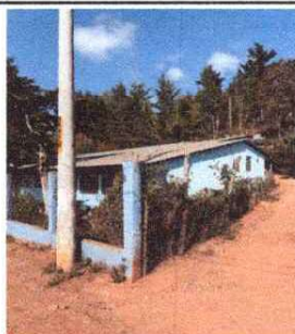
Foto 3: CERCO O MURO PERIMETRAL
