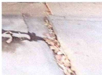
Foto 4: LOSA DE PATIO
