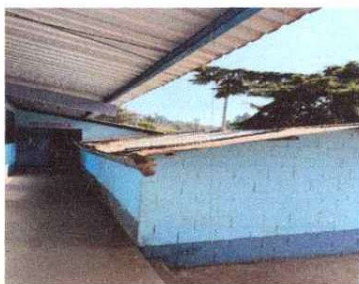
Foto1: CUBIERTA DE LAMINA
