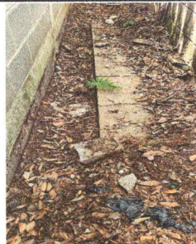
Foto 2: Cambio de cuneta por daño.
