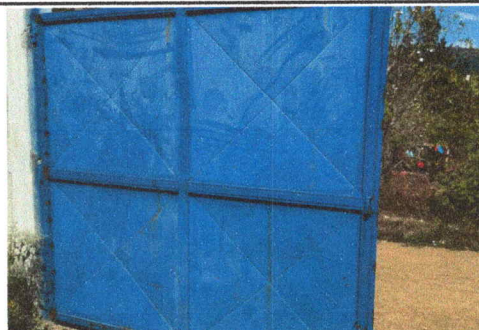
Foto 6: Reparación de porton en mal estado.
