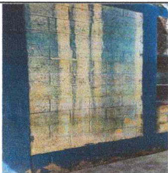
Foto 3: PINTURA EN MUROS INTERIOR Y EXTERIOR
