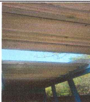
Foto 2: SUSTITUCIÓN ESTRUCTURA DE TECHO
