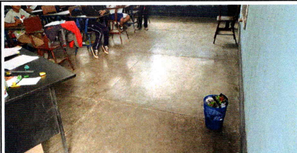
Foto 3: sustitucion de piso
