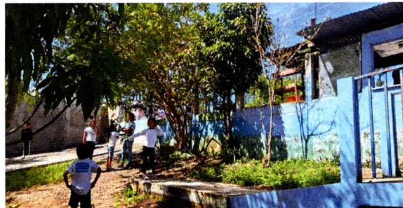
Foto 2: sustitucion de muro perimetral
