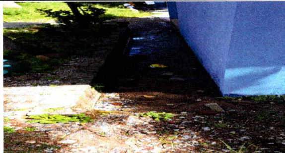
Foto 4: reparacion de cunetas
