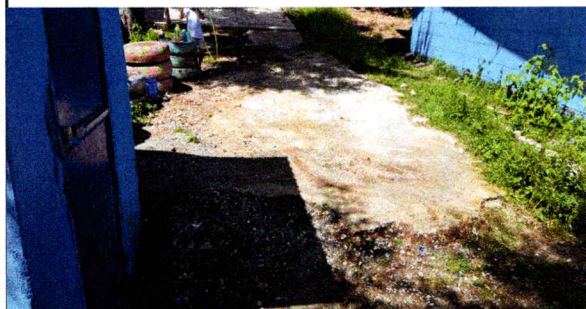
Foto 1: Sustitucion de losa de patio
