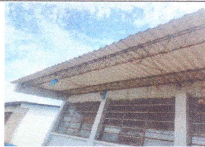
Foto 2: SUSTITUCIÓN ESTRUCTURA DE TECHO
