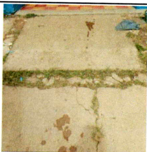
Foto 3: SUSTITUCIÓN LOSA DE PATIO INCLUY BASE, FUNDICION Y ACABADO
