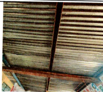
Foto 2: SUSTITUCIÓN ESTRUCTURA DE TECHO
