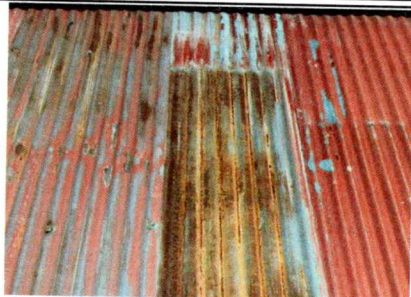
Foto 1: SUSTITUCIÓN LAMINA TROQUELADA CALIBRE 26
