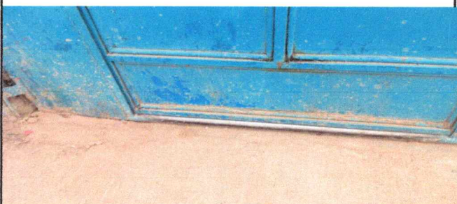
Foto 5: reparación y pintado de portón
