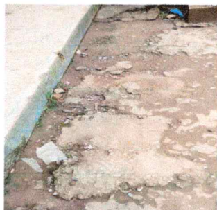
Foto1: sustitución de la losa de patio, la cual esta muy deteriorada
