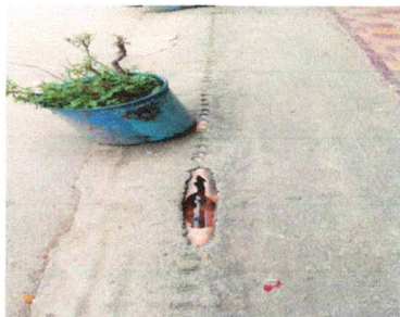
Foto 3: sustitución de tubería de drenajes.
