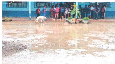
Foto 2: reparación de losa de patio, para evitar la acumulación de aguas pluviales en el patio de la escuela
