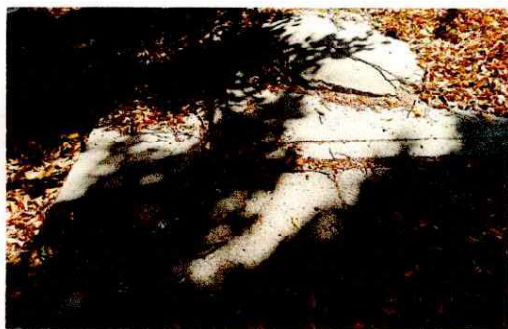
Foto 1: LOSA DE PATIO
