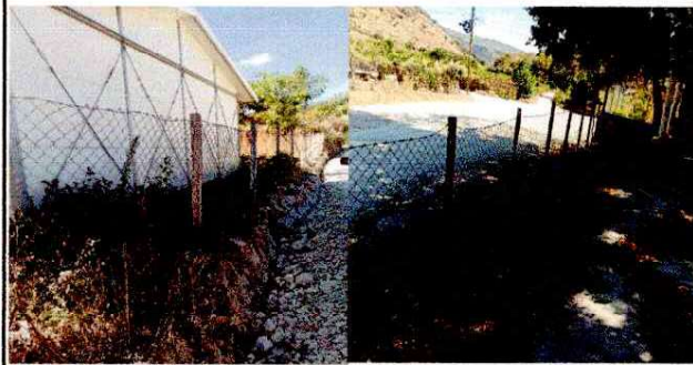
Foto 2: SUSTITUCION POSTES DE CONCRETO Y MALLA
