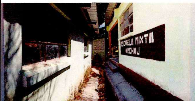
Foto 3: PINTURA EN MUROS INTERIOR Y EXTERIOR
