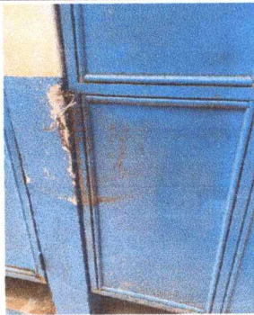
Foto 5: REPARACIÓN Y MANTENIMIENTO PUERTAS EN AREA DE BAÑOS
