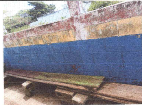
Foto 4: PINTURA EN MUROS INTERIOR Y EXTERIOR
