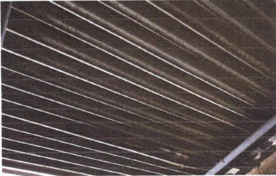
Foto 1: SUSTITUCIÓN LAMINA TROQUELADA CALIBRE 26
