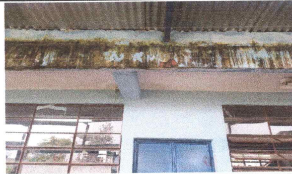
Foto 6: IMPERMEABILIZACIÓN DE LOSA POR SELLADOR TIPO PINTURA
