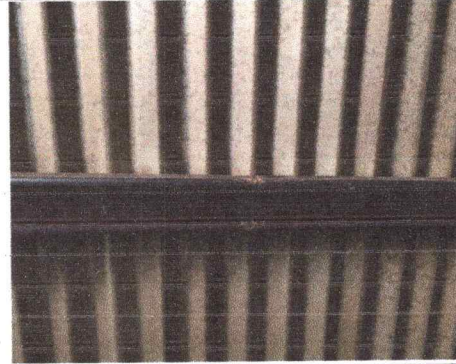
Foto 2: SUSTITUCIÓN ESTRUCTURA DE TECHO
