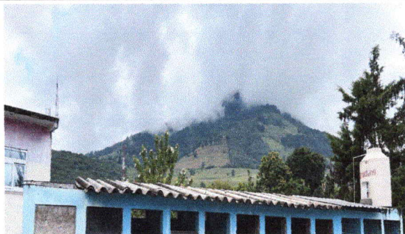
Foto 1: SUSTITUCIÓN LAMINA TROQUELADA CALIBRE 26
