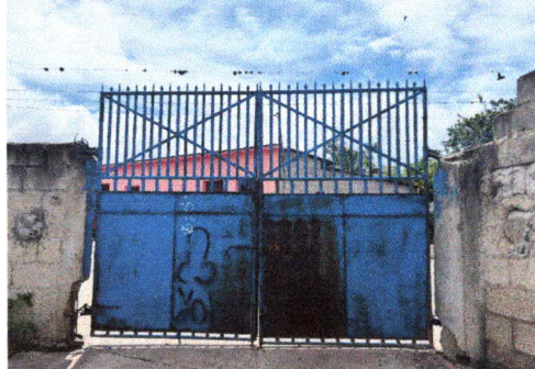
Foto 2: SUSTITUCION DE PORTON DE TUBO CON LAMINA LISA (PROMEDIO 3X2MTS)
