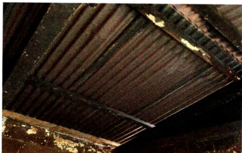
Foto1: SUSTITUCION DE LAMINA TROQUELADA CALIBRE 26
