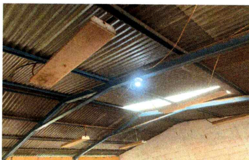
Foto 5: SUSTITUCION DE SISTEMA ELECTRICO
