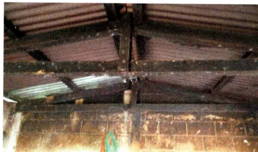
Foto 2: SUSTITUCION DE ESTRUCTURA DE TECHO
