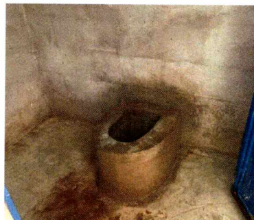
Foto 4:SUSTITUCION DE SANITARIO COMPLETO
