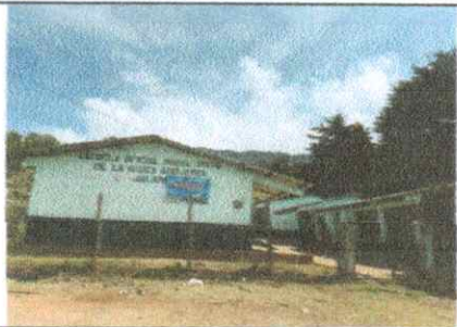
Foto 1: SUSTITUCIÓN DE CERCO PERIMETRAL CON BLOCK Y MALLA
