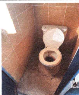
Foto 3: Cambio de sanitario.
