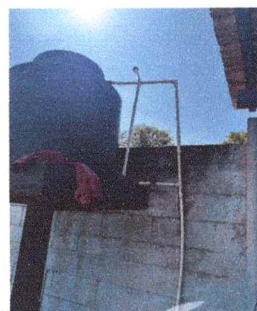
Foto 6: Reparacion de tuberia hacia la pila
