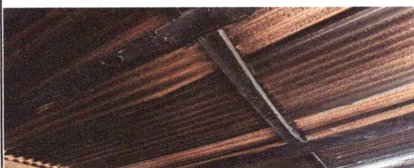
Foto 5: Reparación de estructura de techo.
