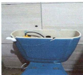
Foto 5: SUSTITUCION DE SERVICIOS SANITARIOS
