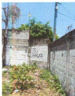
Foto 4: CERCO O MURO PERIMETRAL
