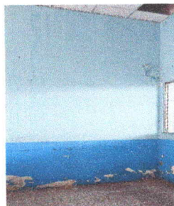
Foto 2: PINTURA EN MUROS EXTERIORES E INTERORES
