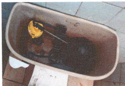
Foto 3: REPARACION DE SERVICIOS SANITARIOS
