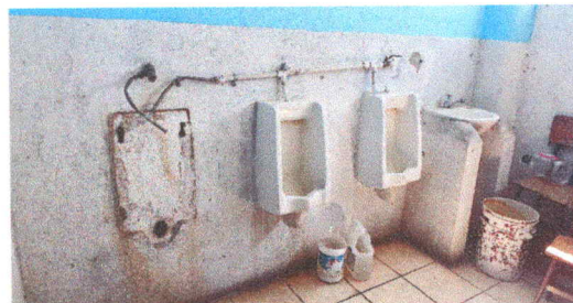
Foto 4: REPARACION E INSTALACION DE URINAL
