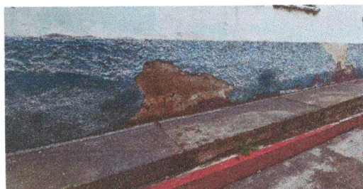
Foto 5: SUSTITUCION DE REPELLO Y CERNIDO EN PAREDES
