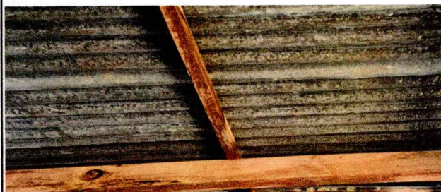
Foto 3: Cambio de la estructura de techo.
