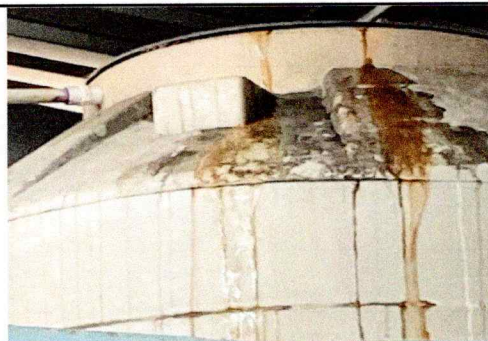
Foto 5: sustitucion de deposito de agua
