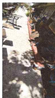
Foto 4: CANALES Y BAJADAS DE AGUA PLUVIAL
