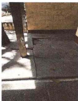
Foto 3: LOSA DE PATIO
