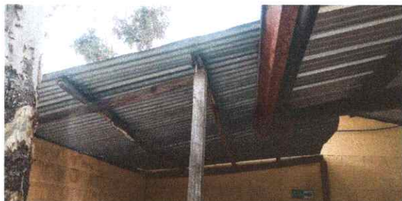
Foto1: SUSTITUCION DE ESTRUCTURA Y LAMINA TROQUELADA (calibre26)
