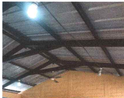
Foto 2: REPARACION DE SISTEMA ELECTRICO
