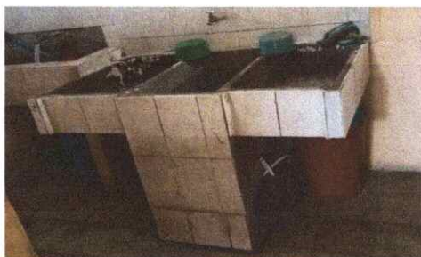
Foto 5: REPARACION O SUSTITUCION DE AREA DE BAÑOS
