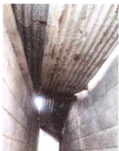
Foto1: CUBIERTA DE LAMINA
