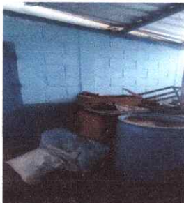
Foto 3: CERCO O MURO DE CONCRETO
