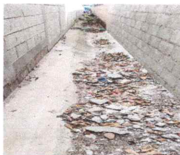
Foto 2: Fundicion piso de cemento
