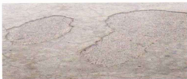
Foto 5: Sustrucción de piso
