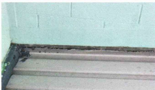
Foto 1: Sustrucción de techo
