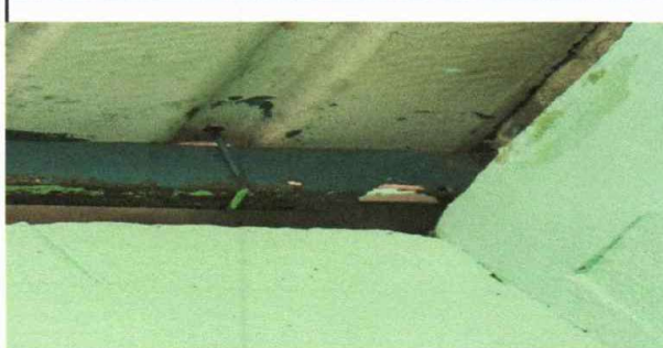
Foto 2: sustitucion estructura de metal
