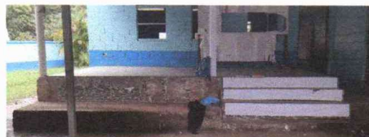
Foto 4: Sustitución de piso
