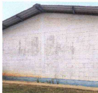
Foto 2: Pintura en muros interiores y exteriores
