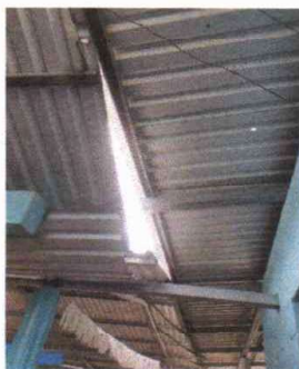
Foto1: Sustitución de canal de metal
