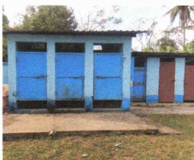
Foto 3: Mantenimiento a estructura
