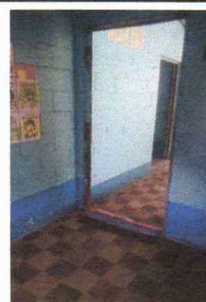
Foto 6: Fabricación e instalación de puertas en módulos
