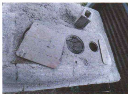
Foto 4: Sustitución de plancha de metal de 3 hornillas
