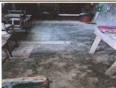
Foto 5: Sustitución de piso de granito
