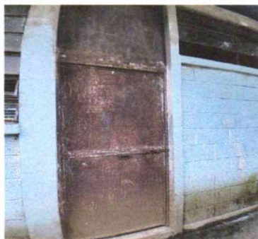
Foto 1: Fabricación e instalación de puertas de metal en módulos
