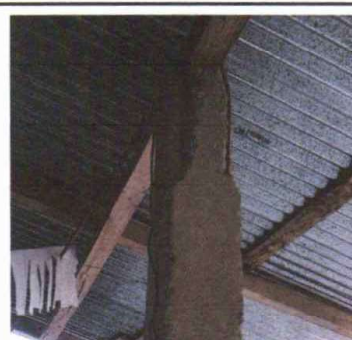
Foto 6: Reparación de columnas
