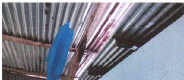
Foto 3: Desinstalación de lámina existente, desinstalación de estructura portante, sustitución de lámina por lámina troquelada aluzina calibre 26 y sustitución de estructura de soporte de madera por metal
