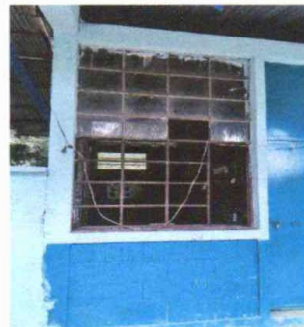
Foto 2: Fabricación e instalación de balcón de hierro en ventanas
