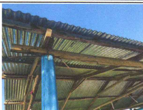
Foto 2.1: Sustitución de estructura de soporte de madera, por metal
