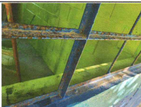
Foto 4.1: Sustitución de balcones de metal 2.47x1
