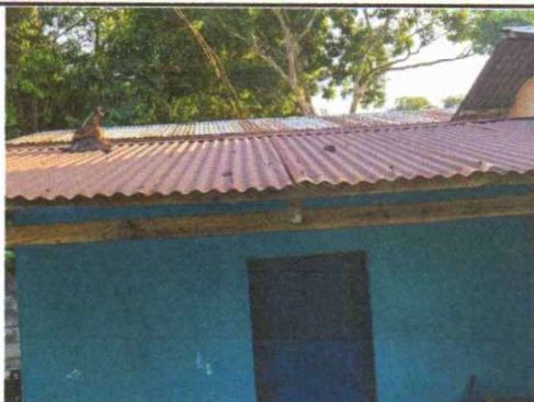
Foto 1.1: Sustitución de lámina, por lámina troquelada aluzinc calibre 26
