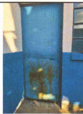
Foto 3.1: Mantenimiento a Estructura (lijado, aplicación de pintura)
