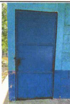
Foto 2.2: Sustitución de Puerta 90x2.10
