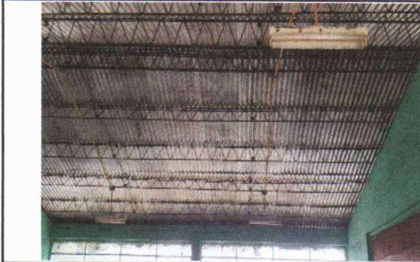
Sustitución de lámina, por lámina troquelada
