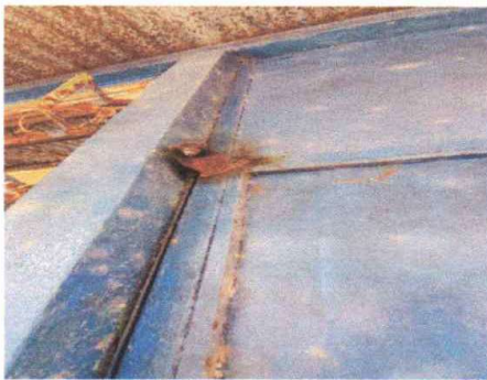
Sustitución de puerta
