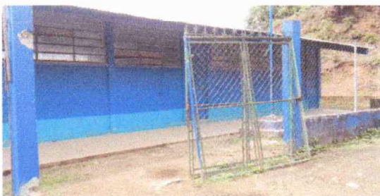
Sustitución de portón de metal
