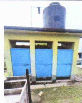
Sustitución de puerta en servicios sanitarios
