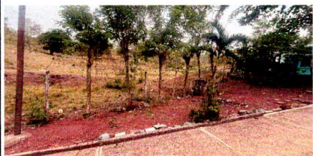
Foto 1: reparación de cerco
