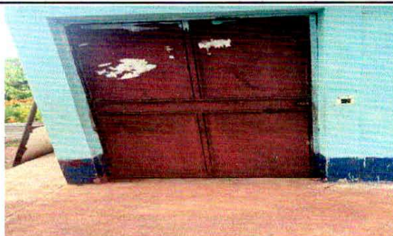
Foto 2.2: Sustitución de puertas
