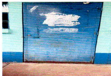
Foto 2.1: Sustitución de puertas
