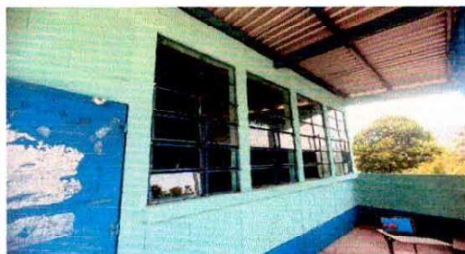
Foto 3.1: Sustitución de vidrios y estructura de metal
