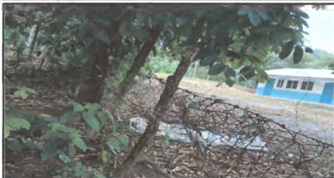
Foto1: Muro Perimetral Reparación de tubo hg y malla galvanizada
