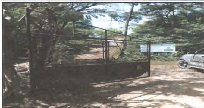
Foto 2: Sustitución de portón de metal
