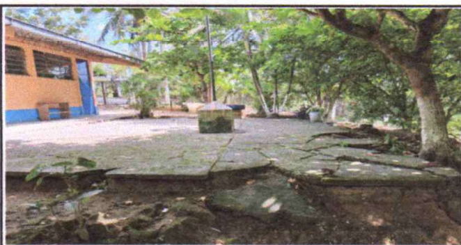
Foto 5: Reparación de planchas de concreto de patio
