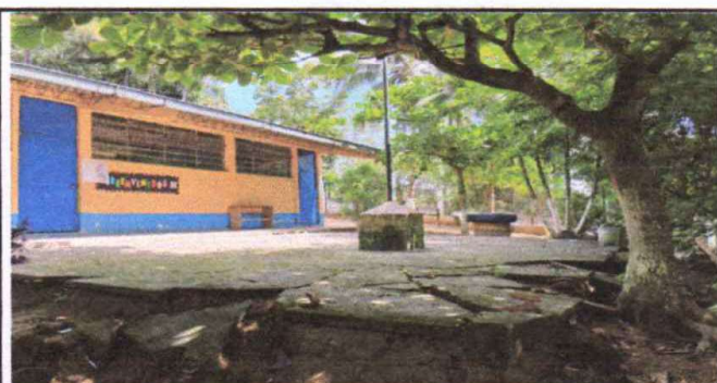
Foto 6: Reparación de planchas de concreto de patio
