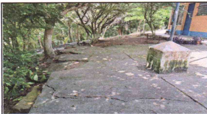
Foto 4: Reparación de planchas de concreto de patio
