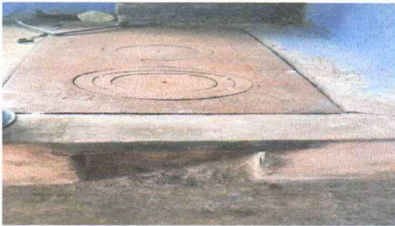
Foto 3: SUSTITUCIÓN DE ESTUFA RURAL (COMPLETA) INCLUYE PLANCHA, CHIMENEA. Y PLANCHA DE METAL
