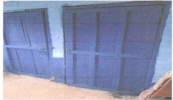
Foto 2: SUSTUCION DE PUERTAS DE MADERA POR METAL
