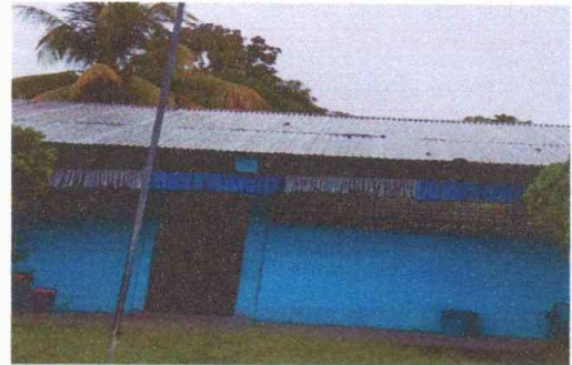
Foto 2: SUSTICIÓN DE LÁMINA POR LAMINA TROQUELADA ALUZINC CALIBRE 26
