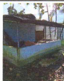
Foto 2: SUSTITUCION DE VENTANAS DE METAL Y MARCO CON TELA DE ARNERO
