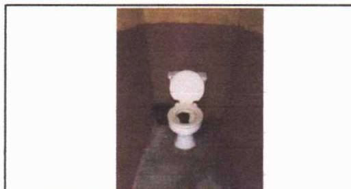
Foto 8: SUSTITUCION DE SANITARIOS EN SERVICIOS SANITARIOS
