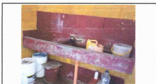
Foto 10: INSTALACION DE AZULEJO EN LAVADEROS DE CEMENTO EN SERVICIOS SANITARIOS
