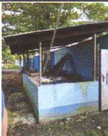
Foto 1: SUSTITUCION DE TECHO Y CUBIERTA DE METAL CON LAMINA CALIBRE 26
