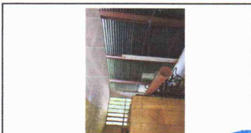
Foto 11: CAMBIO DE UBICACIÓN DE LAMPARAS ELECTRICAS EN SERVICIOS SANITARIOS
