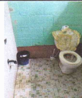
Foto 18: SUSTITUCION DE SANITARIO Y LAVAMANOS EN AREA DE DIRECCION
