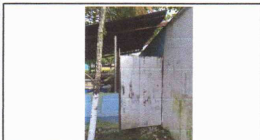
Foto 7: SUSTITUCION DE PUERTA DE METAL CON CHAPA
