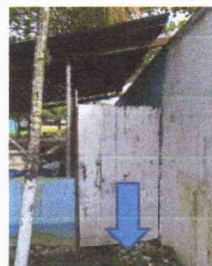
Foto 4: FUNDICION DE PISO DE CEMENTO EN AREA DE PILA
