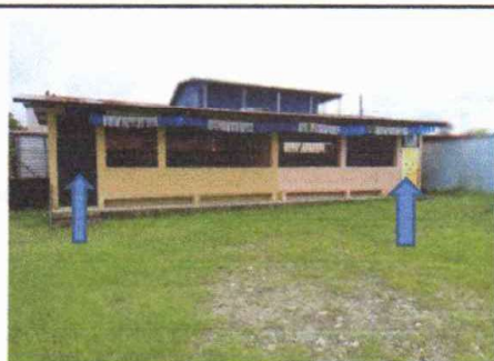
Foto13: SUSTITUCION DE CHAPAS EN PUERTAS DE METAL EN AULA PRE PRIMARIA
