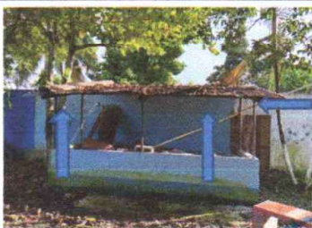
Foto 5: FORRO CON LAMINA GALVANIZADA EN PARTE SUPERIOR DE VENTANAS Y PUERTA
