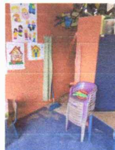
Foto 14: INSTALACION DE PUERTA DE PVC EN SERVICIO SANITARIO EN AULA PRE PRIMARIA
