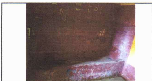
Foto 9: INSTALACION DE AZULEJOS EN URINAL DE CEMENTO EN SERVICIOS SANITARIOS
