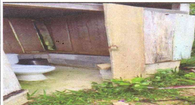
Foto 3: REPARACIÓN Y MANTENIMIENTO DE BAÑO
