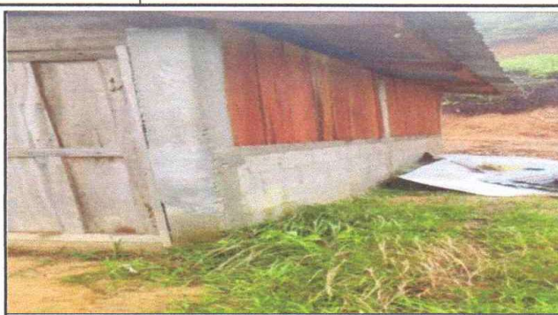
Foto 2: REMOZAMIENTO DE PARED DE COCINA
