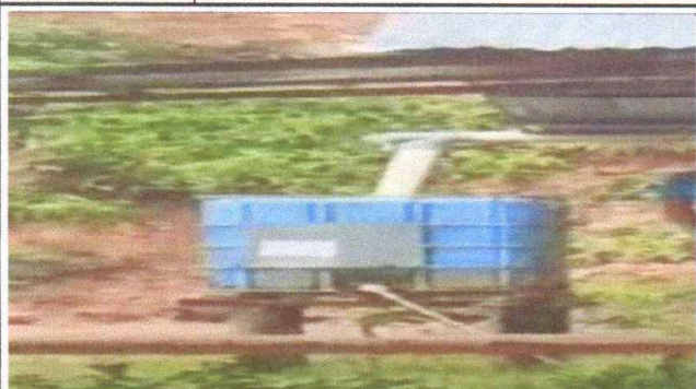
Foto 1: REPARACION Y MANTENIMIENTO TORRE DE ROTOPLAS
