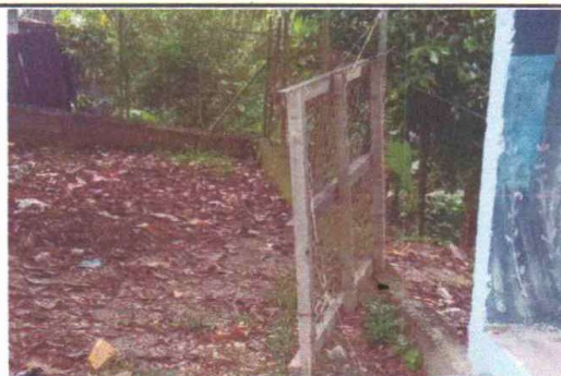
Foto 6: MANTENIMIENTO A PORTON DE PARTE DE ATRÁS
