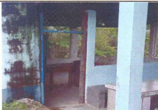
Foto 1: MEJORAMIENTO DE COCINA
