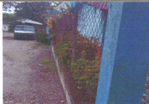
Foto 4: REPARACION DE TUBO HG Y MALLA GALVANIZADA
