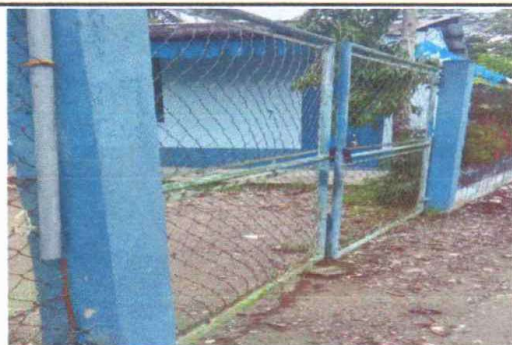
Foto 5: MANTENIMIENTO A PORTON DE METAL DE INGRESO
