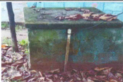
Foto 3: SUSTITUCION DE BOMBA DE AGUA CON SUS ACCESORIOS Y TUBERIA
