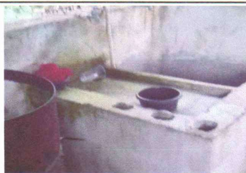
Foto 2: SUSTITUCION DE PILA
