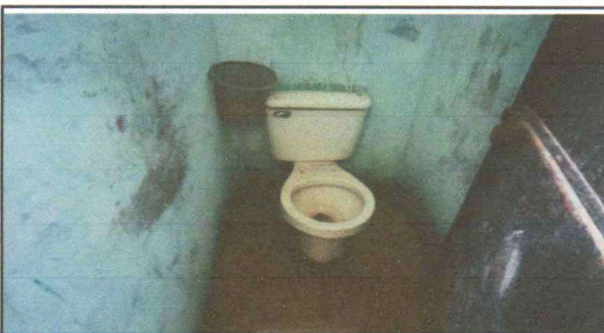
Foto 3: MANTENIMIENTO DE SERVICIO SANITARIO
