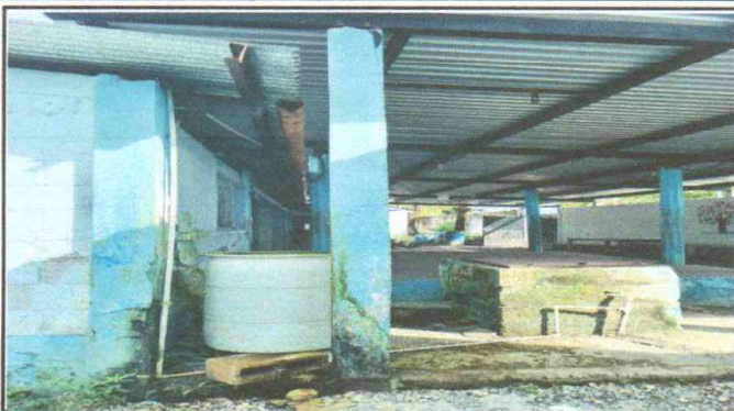
Foto 1: SUSTITUCION DE TUBERIA DE AGUA POTABLE
