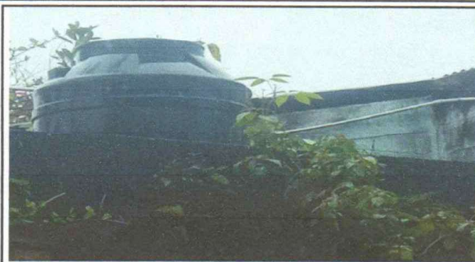
Foto 2: SUSTITUCION DE DEPOSITO DE AGUA.
