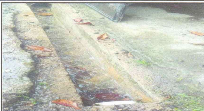
Foto 7: COLOCACION DE REGILLA EN INGRESO AL ESTABLECIMIENTO
