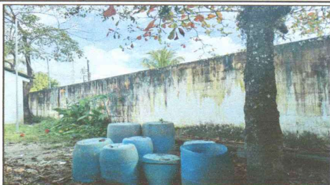
Foto 8: PINTURA EN MURO PERIMENTRAL Y EN MODULOS
