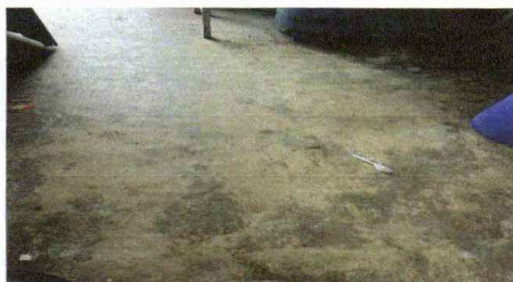
SUSTITUCION DE PISO POR CERAMICA
