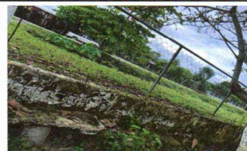
REMOZAMIENTO DE MURO PERIMETRAL DE MAYA
