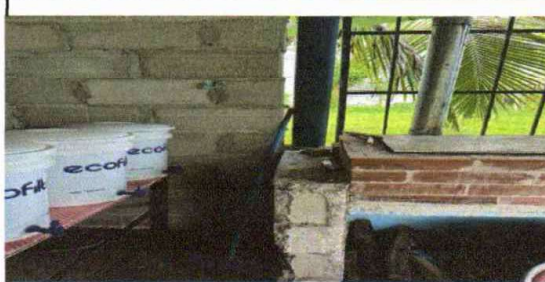
REPARACION DE PARED DE COCINA
