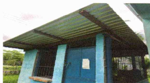
REMOZAMIENTO DE PAREDES DE COCINA
