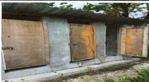
SUSTITUCION DE PUERTAS DE BAÑO DE PLAYBOOK POR PUERTAS DE METAL
