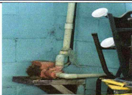
SUSTITUCION DE BOMBA Y ACCESORIOS
