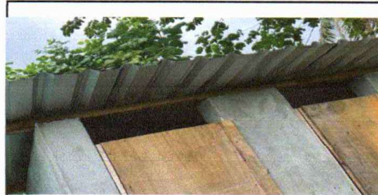
SUSTITUCION DE ESTRUCTURA DE MADERA POR METALICA A BAÑOS
