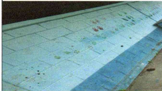
SUSTITUCION DE PINTURA A PAREDES
