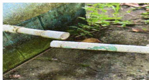
SUSTITUCION DE TUBERIA DE AGUA POTABLE
