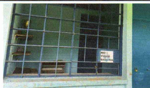
INSTALACION DE MAYA A VENTANA DE COCINA
