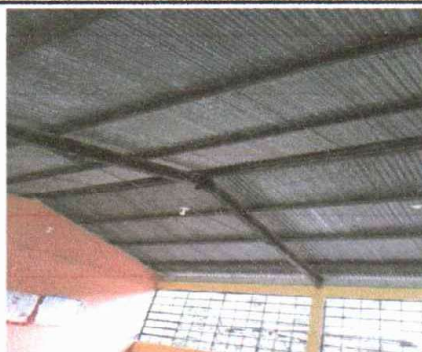
Foto 2: MANTENIMIENTO A ESTRUCTURA DE SOPORTE DE METAL
