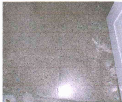
Foto 4: REPARACION O SUSTITUCION DE AZULEJO
