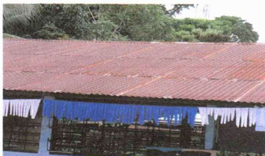
Foto1: SUSTITUCIÓN DE LAMINA POR LAMINA TROQUELADA CALIBRE 26
