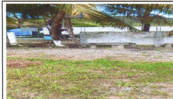
Continuacion de muro perimetral
