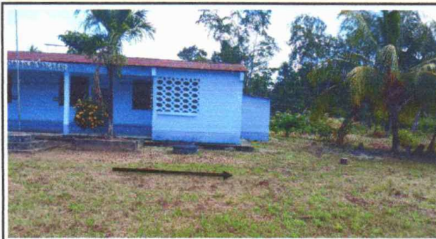
Elaboracion de puerta de metal en muro perimetral
