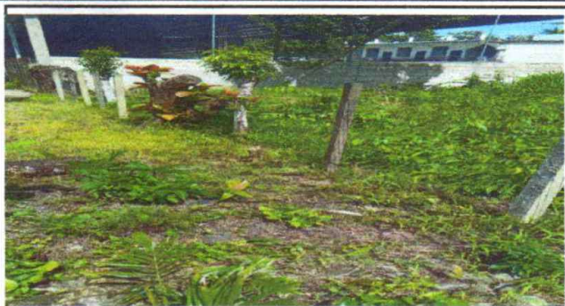
Remozamiento de muro perimetral de block con maya
