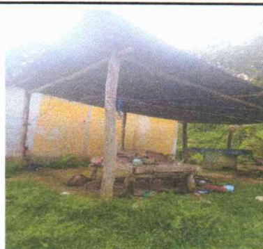
Foto 4: Sustitucion de Pila
