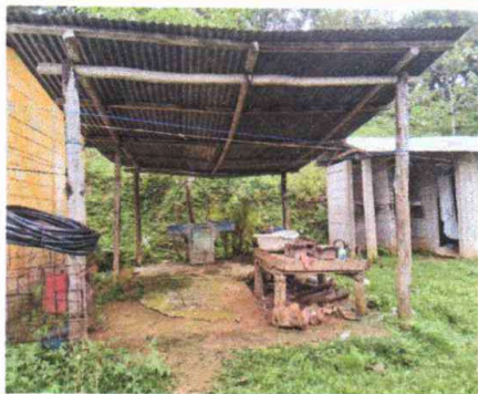
Foto 1: Mantenimiento de Cocina
