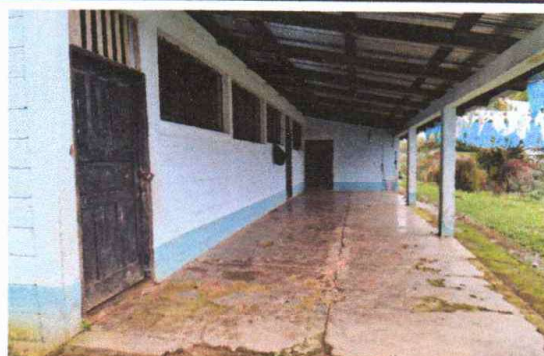
Foto 2: Mantenimiento de Piso de Concreto
