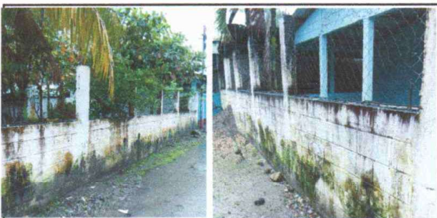
No.5 Muro Perimetral, remozamiento muro perimetral, sustitucion de malla por balcones
