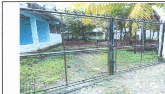
No.6 Porton de Ingreso, remozamiento de Porton de Ingreso
