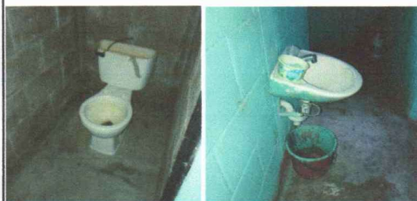
No.3 SERVICIOS SANITARIOS, Sustitucion de inodoro, sustitucion de lavamanos
