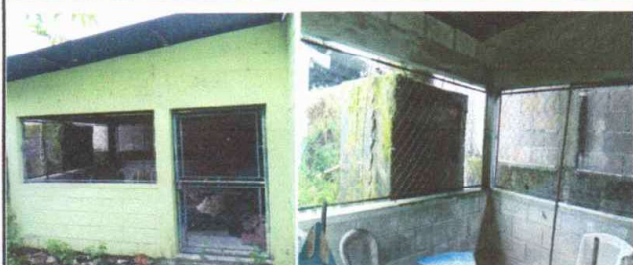
No.1 Remodelacion de Cocina, pintura interior y exterior, sustitucion piso de granito, sustucion de malla a balcones, remodelacion de pila
