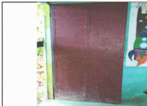
No.4 Sustitucion de Puerta de Metal de Aula
