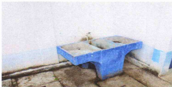
Foto1: Instalación de la pila, con alero
