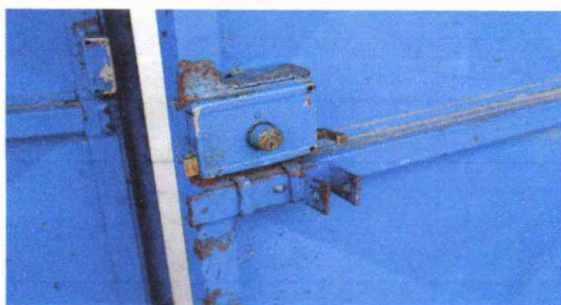
Foto 5: Sustitucion de chapas para puertas
