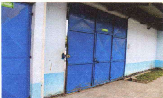
Foto 3: Mantenimiento de portones
