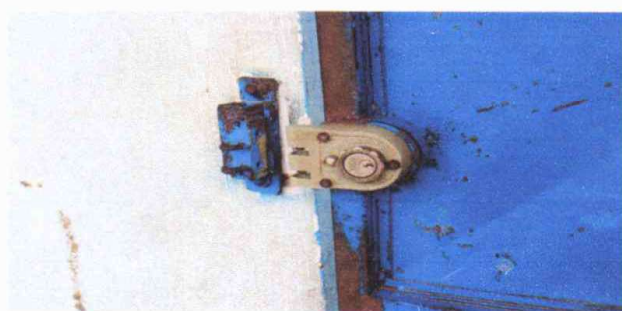
Foto 4: Sustitucion de chapas de los portones
