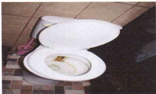
Foto7: Sustitucion de inodoro
