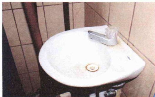
Foto 9: Sustitucion de lavamanos
