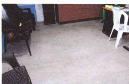
Foto 6: Sustitucion de piso cerámico
