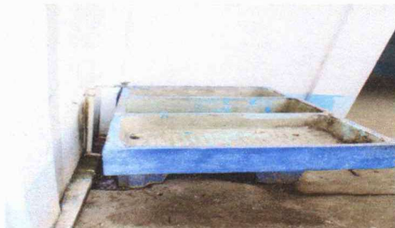
Foto 2: Sustitucion de tubería de pila
