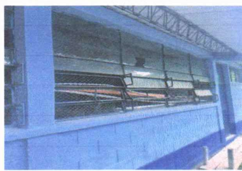
Foto 4: FABRICACIÓN E INSTALACIÓN DE BALCONES
