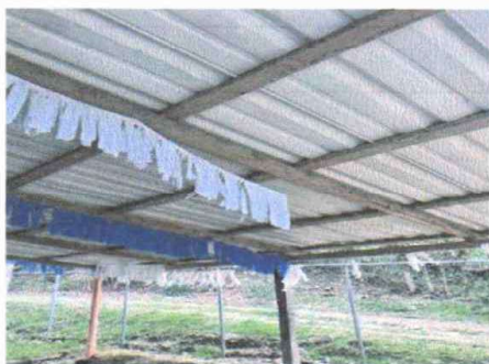
Foto 1: SUSTITUCIÓN DE LAMINA TROQUELADA CALIBRE 26
