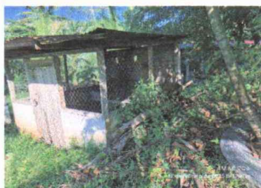
Foto 5: REMOZAMIENTO PARED DE COCINA
