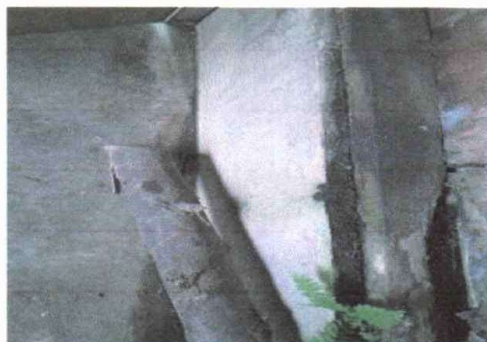
Foto 3: SUSTITUCIÓN DE PISO DE CONCRETO
