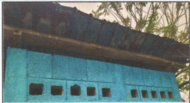
Foto 2: SUSTITUCION LAMINA POR LAMINA CAL 26
