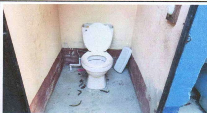
Foto 1: SUSTITUCION DE INODOROS.
