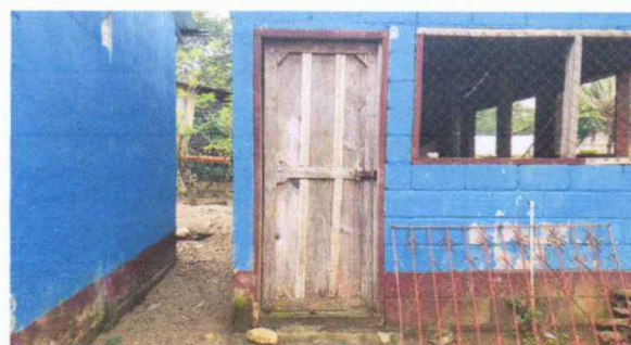
Foto 4: SUSTITUCION DE PUERTA DE METAL
