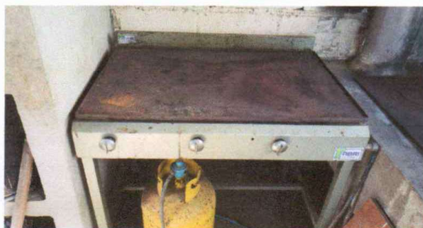
Foto 9: SUSTITUCION DE ESTUFA INDUSTRIAL
