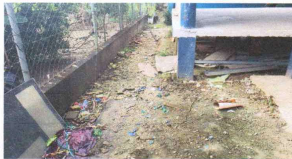
Foto 8: SUSTITUCION DE TUBERIA PVC LINEA PRINCIPAL AGUAS NEGRA
