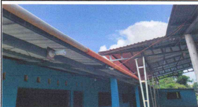
Foto 3: SUSTITUCION DE CANALES DE TUBO PVC A CANALES PVC DURBAN
