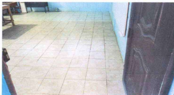
FOTO 10: SUSTITUCION DE PISO
