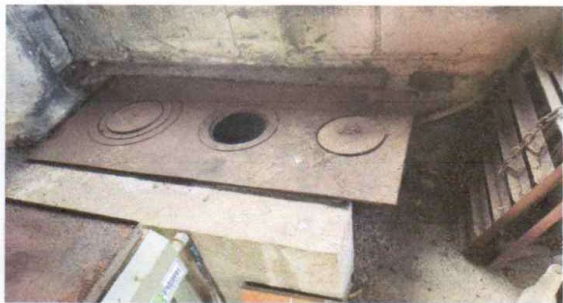
Foto 7: SUSTITUCION DE PLANCHAS DE METAL
