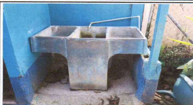
Foto 2: SUSTITUCION DE PILA.
