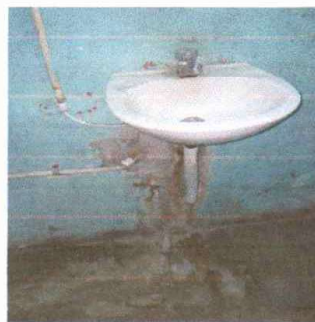
Foto 2: SUSTITUCION DE LAVAMANOS
