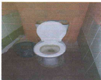
Foto 1: SUSTITUCIÓN DE INODORO
