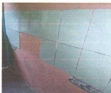
Foto 4: REPARACION O SUSTITUCION DE AZULEJO
