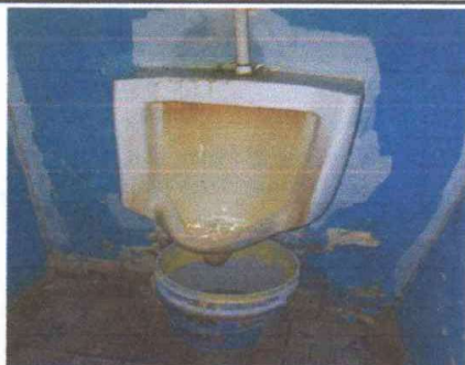
Foto 3: SUSTITUCION DE MIGITORIO
