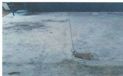
Foto 6: REPARACIÓN O SUSTITUCIÓN DE AZULEJO
