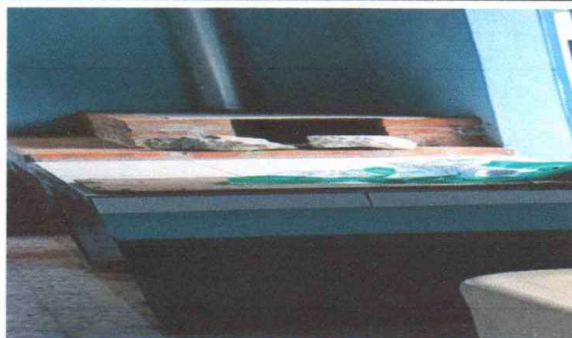
Foto 3: MANTENIMIENTO DE ESTUFA RURAL
