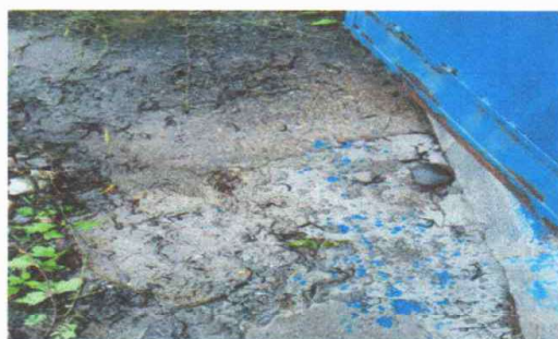
Foto 5: REMOZAMIENTO DE PISO DE TORTA DE CONCRETO
