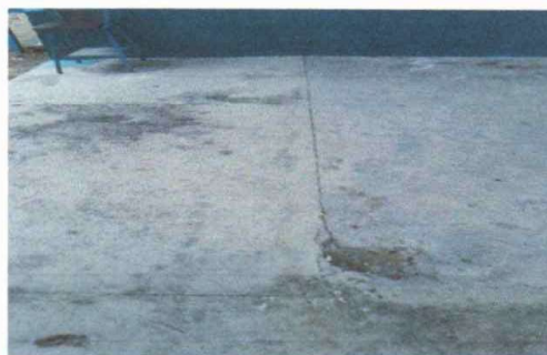
Foto10: REPARACIÓN DE PISO DE GRANITO
