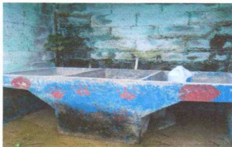
Foto7: SUTITUCIÓN DE LAVAMANOS
