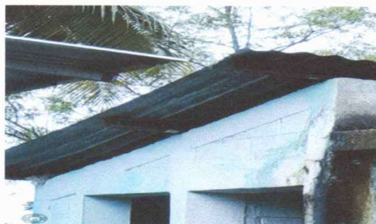
Foto 4: SUSTITUCIÓN DE LAMINA, POR LAMINA TROQUELADA ALUZINC CALIBRE 26
