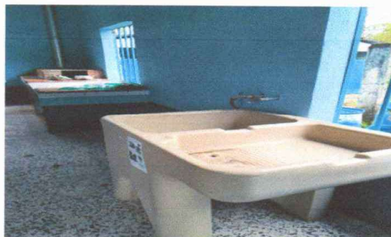
Foto 2: SUSTITUCIÓN DE PILA PLASTICA DE 1 LAVADERO
