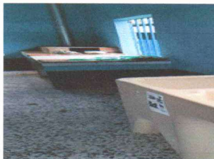
Foto 8: PINTURA DE MUROS INTERIORES Y EXTERIORES
