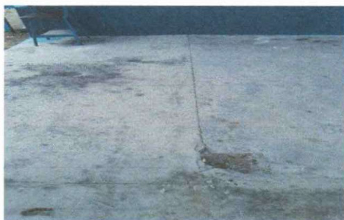
Foto9: REPARACIÓN DE PISO DE GRANITO
