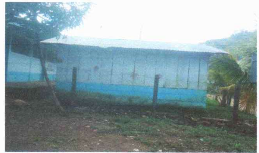
Foto 4: Mejoramiento de paredes de cocina
