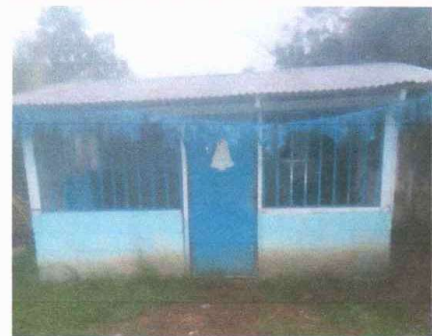
Foto 6: Sustitución de balcones de metal
