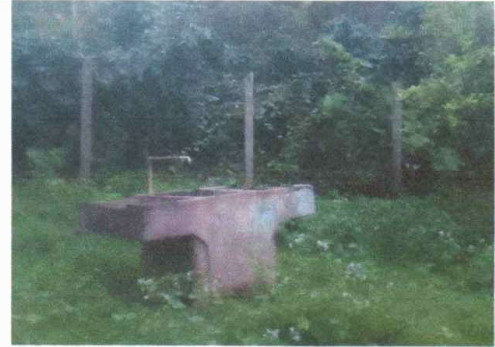
Foto 2: Sustitución de pila de cemento
