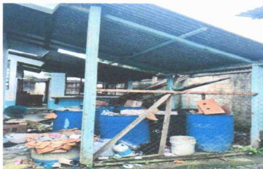
Foto 4: SUSTITTUCION DE ESTRUCTURA DE MADERA POR METAL
