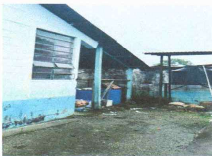
Foto 3: SUSTITUCION DE VIDRIO
