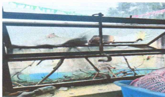
Foto 2: SEGUIMIENTO A ESTRUCTURA DE METAL DE VENTANA
