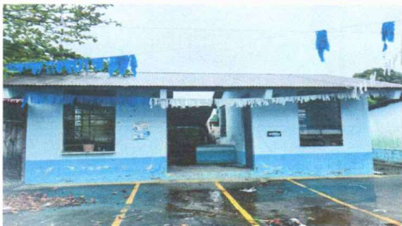
Foto1: SUSTITUCIÓN DE LAMINA, POR LAMINA TROQUELADA CALIBRE 26
