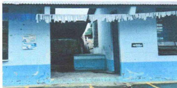
Foto 6: SUSTITUCIÓN DE PUERTA
