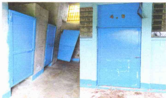
Foto 5: MANTENIMIENTO A ESTRUCTURA (LIJADO, CAMBIO DE TUBO, CEPILLADO, SUJECCIONES APLICACIÓN DE PINTURA A PUERTAS DE BAÑO Y AULAS
