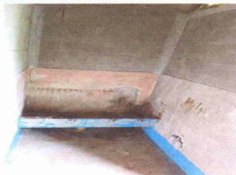
Foto 3: SUSTITUCIÓN DE TUBERÍA PVC LINEA PRINCIPAL AGUAS PLUVIALES
