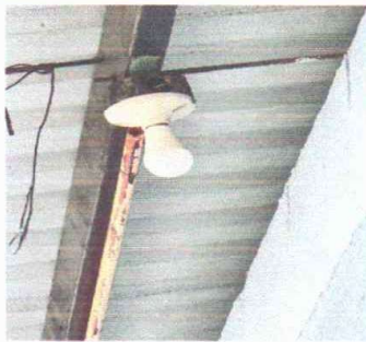
Foto 3: SUSTITUCION DE FOCOS AHORRADORES
