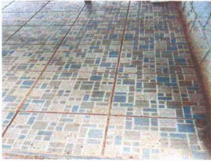
Foto 1: SUSTITUCIÓN DE PISO DE CERAMICO
