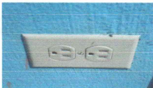
Foto7: SUSTITUCION DE TOMACORRIENTE DOBLE
