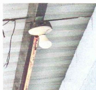
Foto 4: SUSTITUCION DE PLAFONERAS
