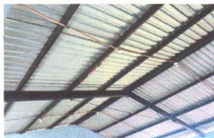
Foto 8: SUSTITUCION DE DUCTO ELECTRICO + ACCESORIOS
