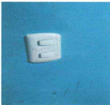
Foto 9: Sustrucción interruptores dobles
