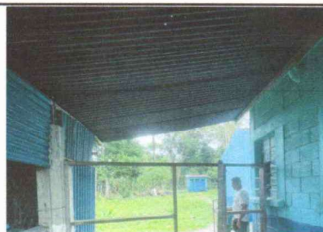
Foto 6: Sustitución de estructura de soporte de madera, por metal
