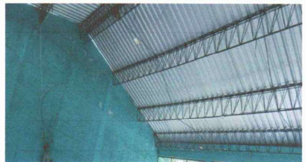
Foto 10: Reparación de cableado eléctrico
