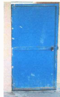
Foto 2: Sustitución de puerta de cocina y bodega
