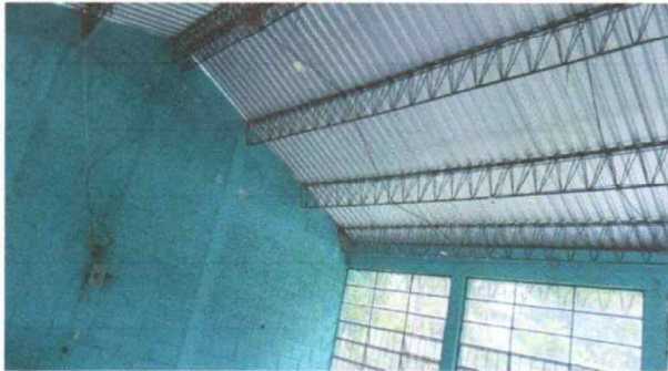
Foto 7 :Sustrucción de ducto eléctrico + accesorios
