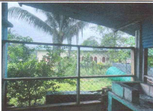
Foto1: Mejoramiento de ventanas
