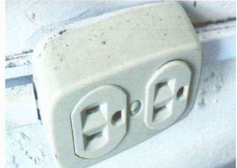
Foto 8: Sustrucción de tomacorrientes dobles
