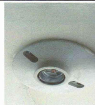
Foto 12: Sustrucción de plafoneras
