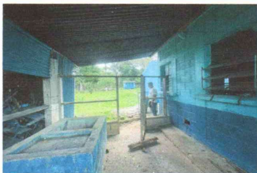
Foto 3: Sustitución de piso de torta de concreto
