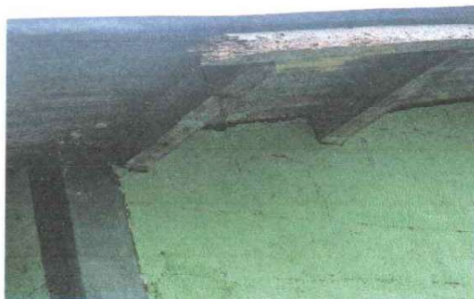
Foto 3: Remozamiento de cocina cambio de vigas de madera del techo por costaneras de metal.
