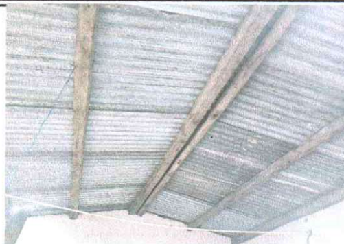
Foto 2: Remozamiento de cocina Sustitución de techo
