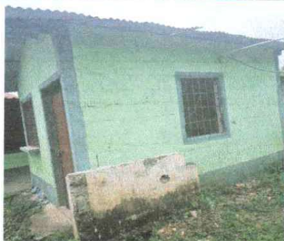
Foto 1: Remozamiento a la cocina escolar.
