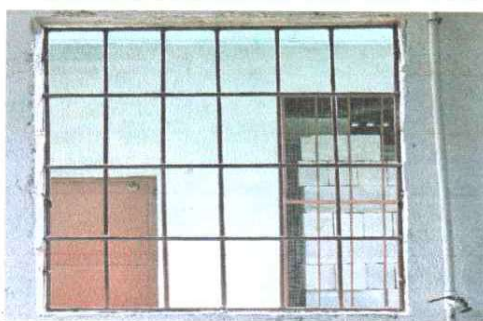
Foto 5: Remozamiento de cocina sustitución de ventanales
