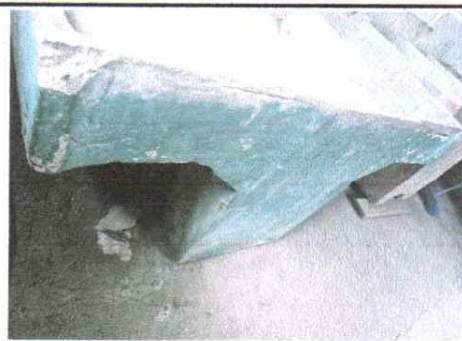
Foto 4: Remozamiento de cocina cambio de pila con su respectivo chorro
